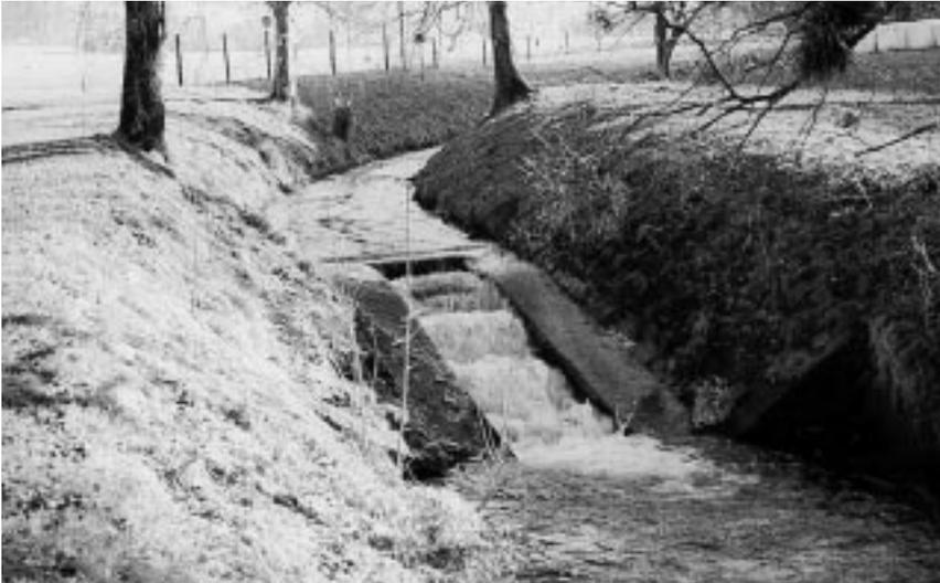
Verbauter Reppischlauf mit künstlicher Rampe (Höhe ca. 1.3 Meter) kurz unterhalb Aumüli
