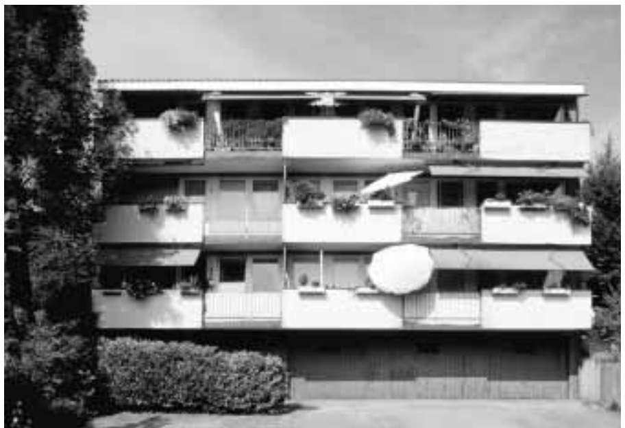
Ansicht des Mehrfamilienhauses in Männedorf vor der Sanierung ...
