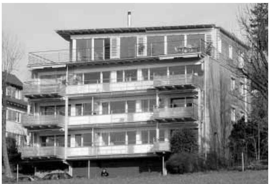
... und nach der Sanierung nach MINERGIE-Standard.
