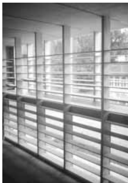
Blick ins Innere der neuen Mediathek: Bücherregale bilden die Tragstruktur. Quelle: HBA Kanton Zürich
