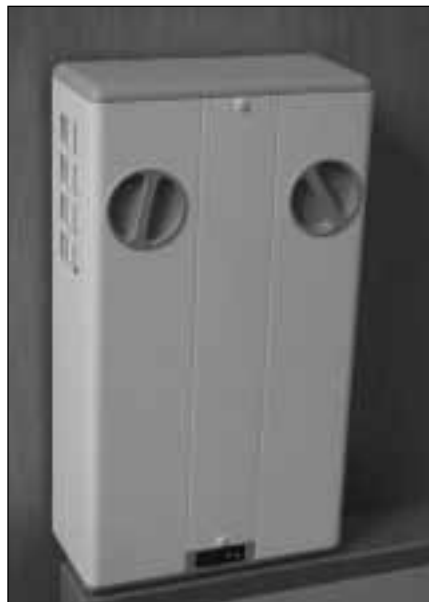
Vor allem in Schlafräumen werden heute gleichzeitig mit Schallschutzfenstern oft auch Zimmerlüfter eingebaut. Aus energetischer Sicht sind zentrale Lüftungsanlagen allerdings vorteilhafter. Quelle: FALS
