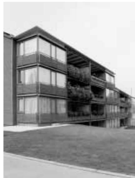
Die Erneuerung der Siedlung der Genossenschaft Waidmatt an der Wehntalerstrasse in Zürich. Die mit einer Anerkennung ausgezeichnete Sanierung zeigt, wie Baumängel und Komfortprobleme beseitigt und attraktive Familienwohnungen mit hohem Wohnwert geschaffen werden können. Quelle: AWEL
