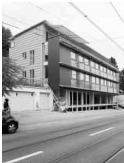
Die Sanierung des Wohn- und Gewerbehouses an der Limmattalstrasse 38 in Zürich. Das mit einer Anerkennung ausgezeichnete Projekt ist in energietechnischer Hinsicht sehr weitgehend und in überzeugender Art optimiert und dokumentiert ein besonderes Engagement für erneuerbare Energien. Quelle: AWEL
