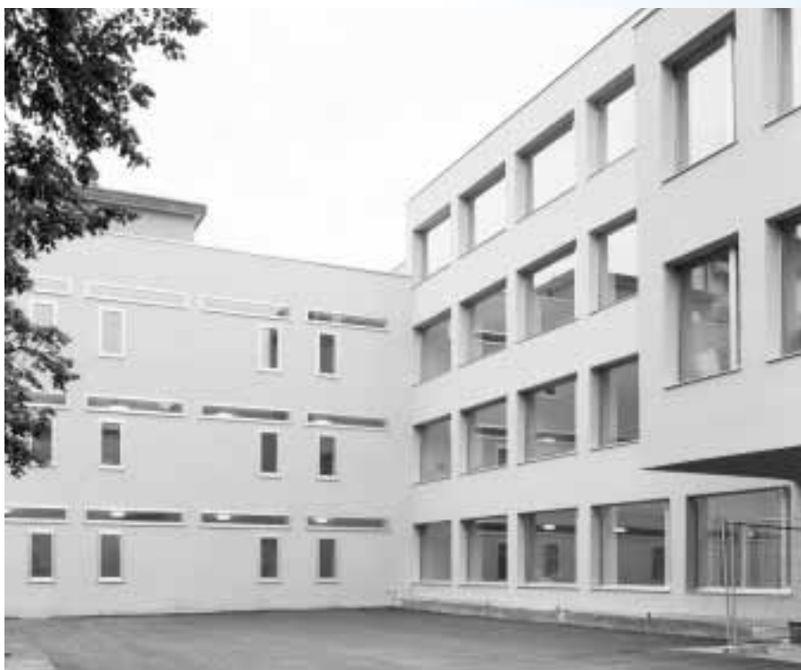
Die Heilpädagogische Schule in Zürich-Wiedikon nach der Sanierung. Das mit dem MINERGIE-Preis ausgezeichnete Gebäude demonstriert exemplarisch, dass Gebäudesanierungen nicht lediglich technische Massnahmen zur Senkung des Energieverbrauchs darstellen, sondern eines klaren, architektonischen Konzeptes bedürfen.
