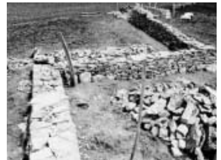
Rekonstruktion einer Trockenmauer: Lebensraum für seltene Tiere. Quelle: Schweizer Heimatschutz
