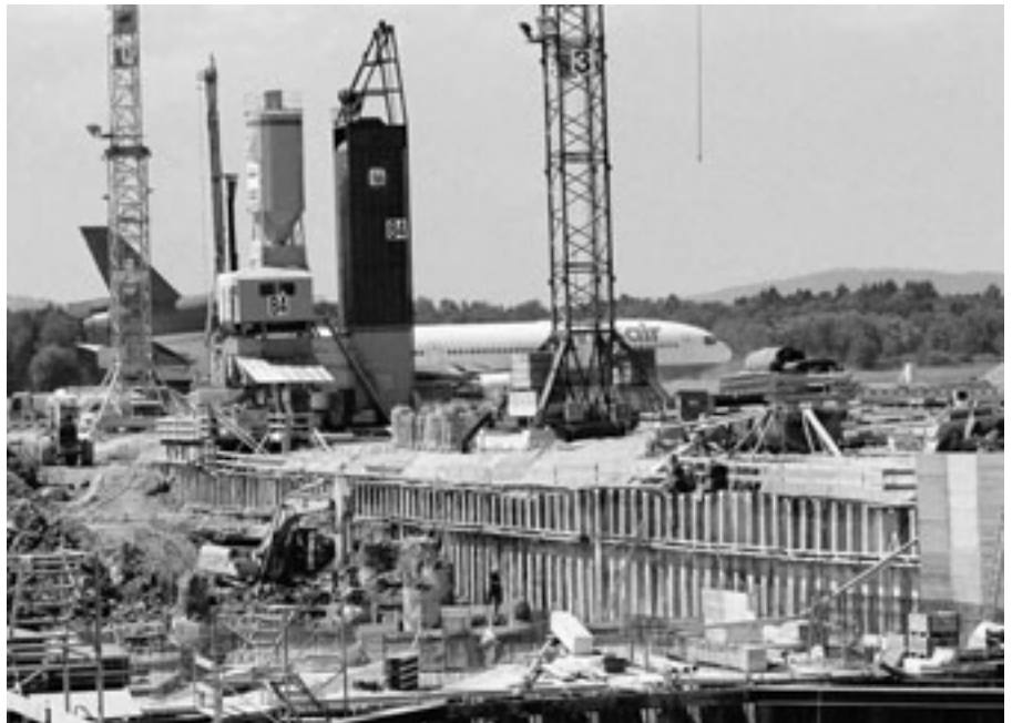
In der Planungsphase sind die Möglichkeiten, Nachhaltigkeitsanforderungen zu berücksichtigen, am grössten. In der Bauphase gibt es nur noch wenig Spielraum, um Versäumtes nachzuholen. Quelle: Unique
