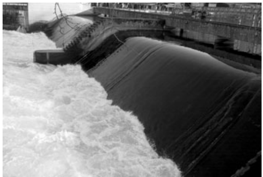
Das Lettenwehr am Ende des Platzspitzes regelt, wieviel Seewasser die Limmat hinunter fliesst.
