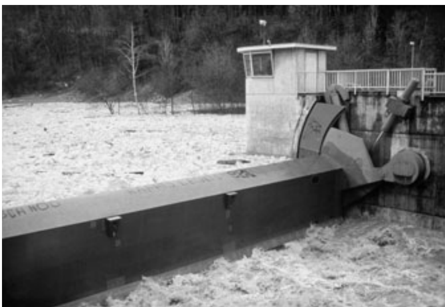
... das Eiswehr bei der Sihlhochstrasse verhindert dies.
