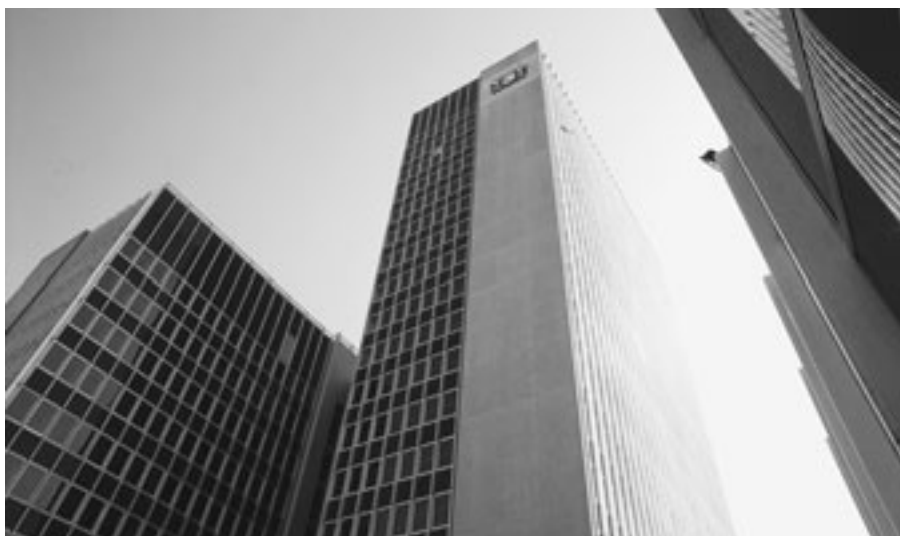
Das anfangs Siebzigerjahre erbaute heutige Verwaltungszentrum Werd der Stadt Zürich enthielt keinen Spritzasbest und war demnach nicht im Kataster aufgeführt. Trotzdem musste eine sehr aufwändige Asbestsanierung durchgeführt werden, insbesondere wegen der vielen Kilometer asbesthaltiger Rohrleitungsverkleidungen und Brandabschottungen.
