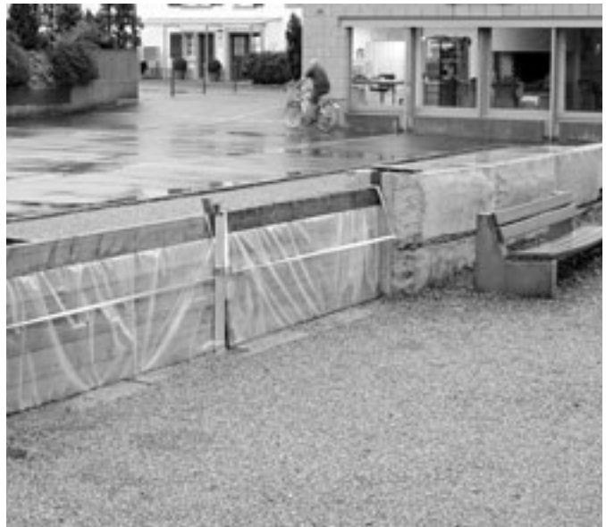
Neben Hochwasserschutzmassnahmen direkt an den Gewässern helfen mobile Massnahmen, grössere Schäden zu verhindern. Dazu gehören zum Beispiel Barrieren aus Sandsäcken oder andere Absperrungen wie hier am Bahnhof Wädenswil (Bild links) und in Adliswil (Bild rechts).
