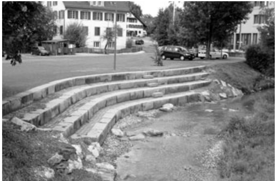
Der Haselbach in Knonau wurde am Stampfiplatz hochwassersicher ausgebaut und gleichzeitig durch naturnahe Gestaltung aufgewertet.
