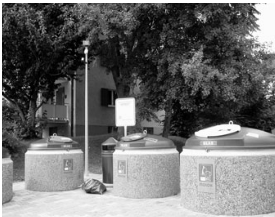
Gemeinesammelstelle mit halb-unterirdischen Containern. Durch das grössere Volumen müssen die Container weniger oft geleert werden. Quelle: AWEL
