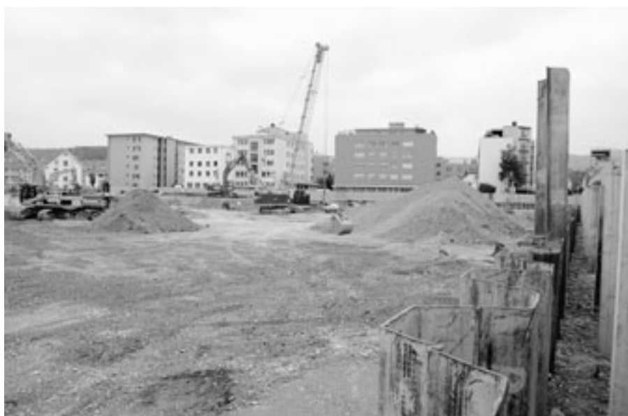
Bei Bauarbeiten muss mit Altlasten belasteter Bodenaushub korrekt entsorgt werden, die Regelung der Kostentragung dafür ist komplex (siehe Kasten Seite 22). Im Bild: Sanierung Schellerareal Dietikon.
