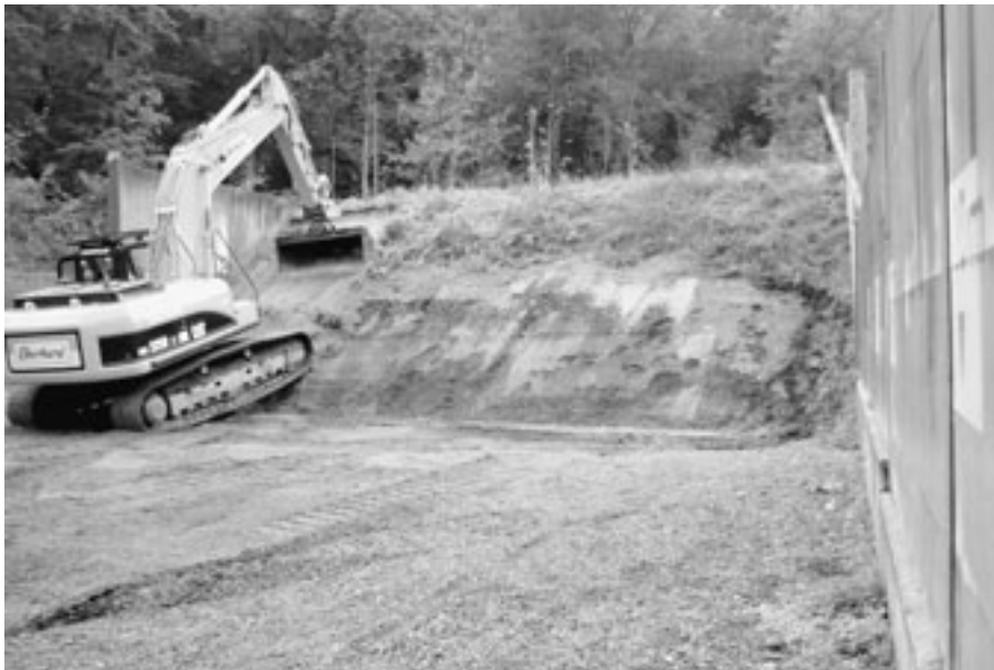
Werden Schiessanlagen stillgelegt, so verschwinden die Bodenbelastungen nur, indem sie ausgebaggert und fachgerecht entsorgt werden.
