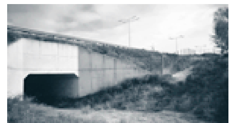
Unterführung für Wildtiere an einer Autobahn (Beispiel aus den Niederlanden). Zäune leiten die Tiere zur Unterführung hin.
