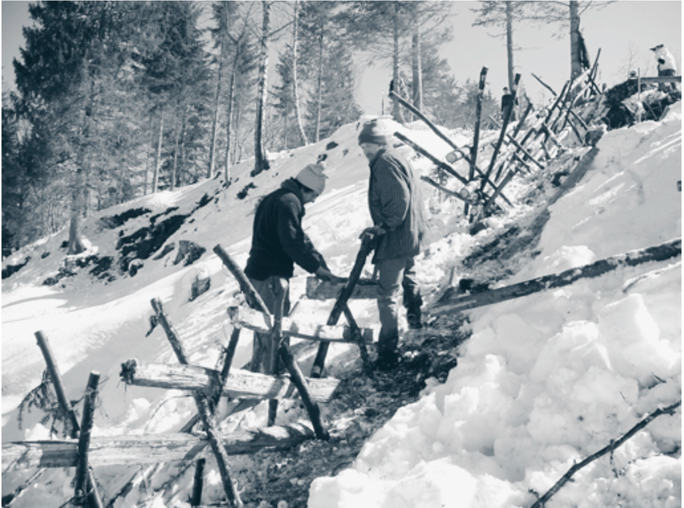
Im Rahmen des Projektes wurde auch der traditionelle, nagellose Zaubau wiederbelebt.
