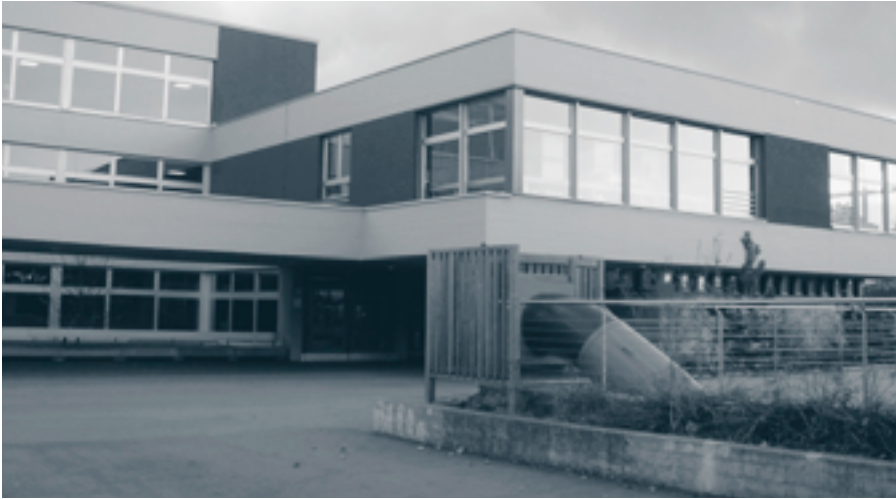
Eine grosse Energieeinsparung bringt die Erneuerung älterer Gebäude nach Minergie-Standard. im Bild: Schulhaus Hasenacker, Männedorf.
