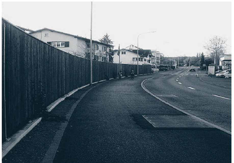
Kombinierte Projekte vereinigen Strassenbau und Lärmschutz. Zusammen mit der Erweiterung des Fussgänger- und Radfahrerbereichs wurde in Hombrechtikon eine Lärmschutzwand erstellt.
