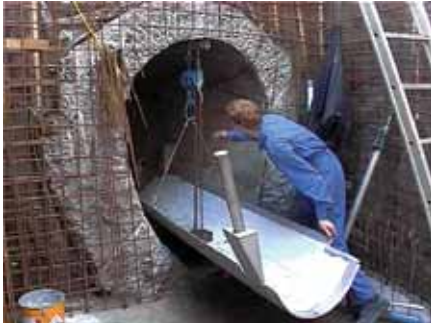
Einbau eines individuell angefertigten Wärmetauschers in einen Kanal.
