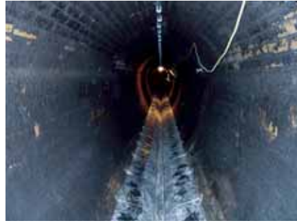
Vorgefertigte Wärmetauscherelemente können auf die Sohle bestehender und neuer Kanäle mit mindestens 80 Zentimeter Durchmesser installiert werden.
