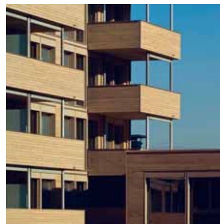
Wohnen in ausgezeichneter Bausubstanz: Die Siedlung Eulachhof in Winterthur mit 136 Wohnungen entspricht dem Standard Minergie-P-Eco (ZH-001-P-Eco und ZH-002-P-Eco). Quelle: Archiv OeJ
