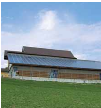
Grossflächige Solaranlage über ganzem Dach. Quelle: Baku
