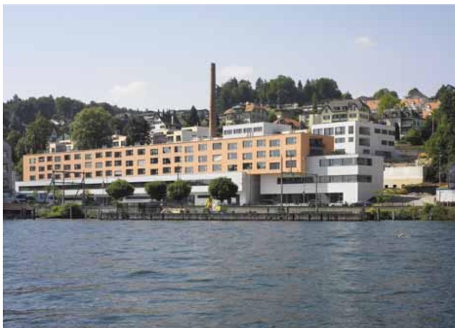
Der Zürichsee ist ein riesiges natürliches Wärmereservoir. In der Siedlung Lagomio in Wädenswil wird Wärme aus dem See mit Wärmepumpen nutzbar gemacht und für Raumheizung und Wassererwärmung eingesetzt.
