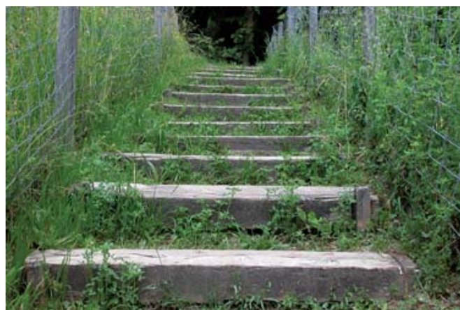
Ausserhalb von Wohnsiedlungen ist das Verbauen von Schwellen teilweise noch gestattet, zum Beispiel für bodentiefe Einfassungen oder Treppen.
