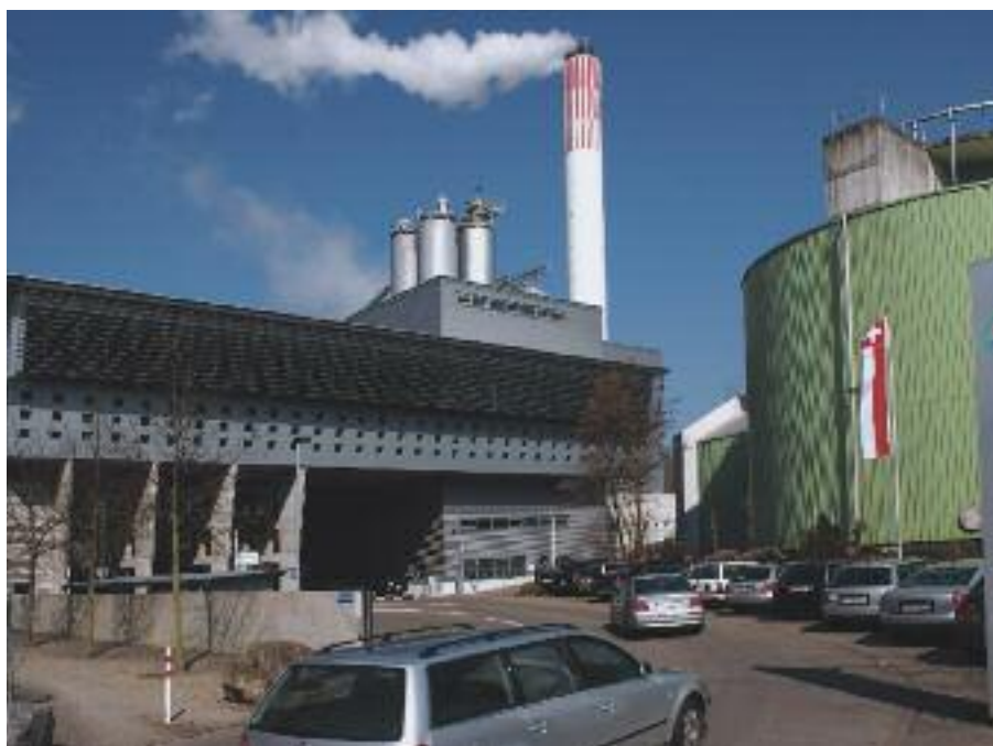
Die energetische Verwertung der Abfälle in einer KVA und der im internationalen Vergleich hohe Grad der stofflichen Verwertung tragen zum Klimaschutz bei.
