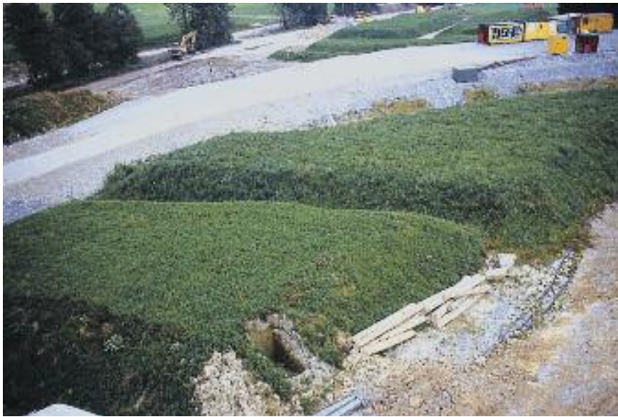
Begrüntes Zwischenlager von Oberboden.
