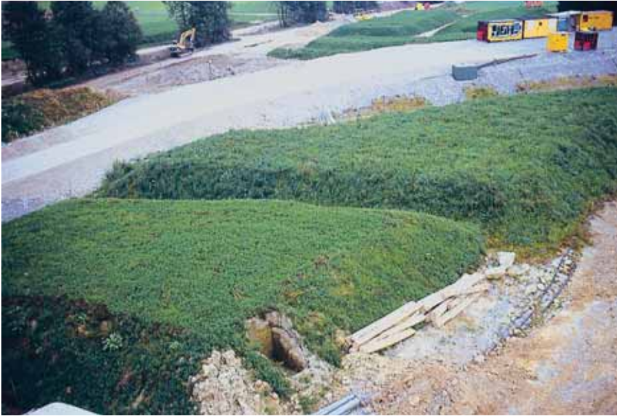
Begrüntes Zwischenlager von Oberboden.
