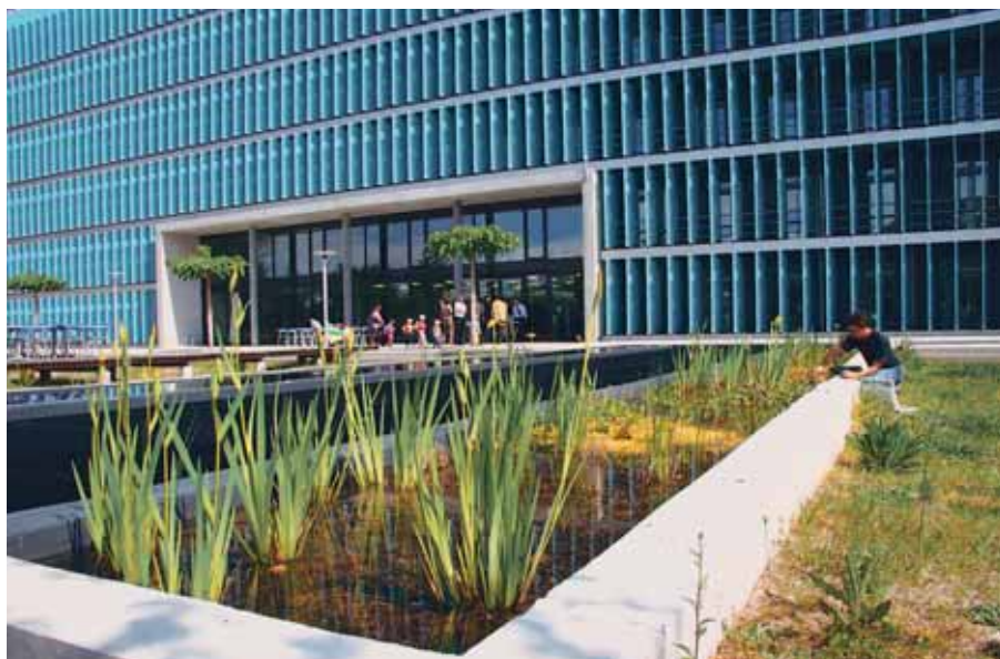
Einzel gesteuerte Lamellen sorgen für den optimalen Lichteinfall. Das Gebäude soll je nach Bedarf zwar durch Sonnenstrahlung erwärmt werden dürfen, aber nicht überhitzen.
