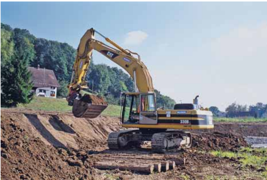
Ein Bagger trägt Boden ab, während er auf einer Baggermatratze steht.
