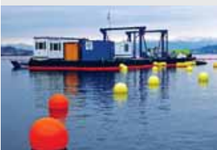
Bei der Sanierung des teerverschmutzten Seegrundes vor Thalwil war im Trinkwasserreservoir Zürichsee besondere Sorgfalt gefordert (Seite 11) Quelle: ARGE Marti Buchen
