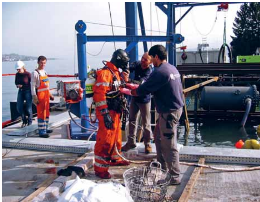
Mit Lampe und Kamera ausgerüstete Taucher saugten mit einem grossen Rohr manuell die verunreinigten Sedimente ab.
