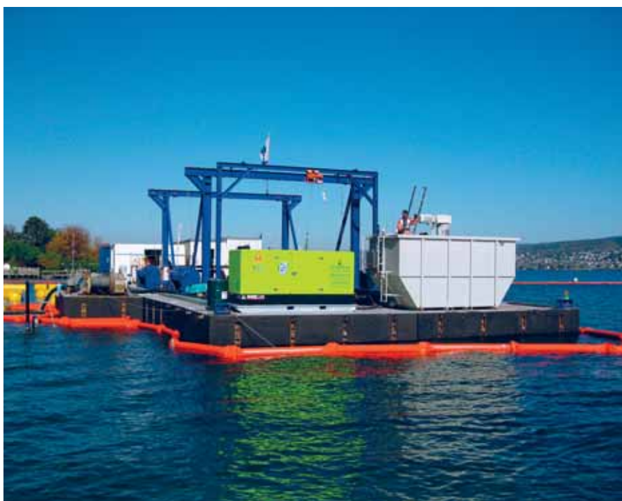
Eine innere Ölsperre umfasste die Sanierungsplattform und eine äussere den ganzen Sanierungsperimeter.
