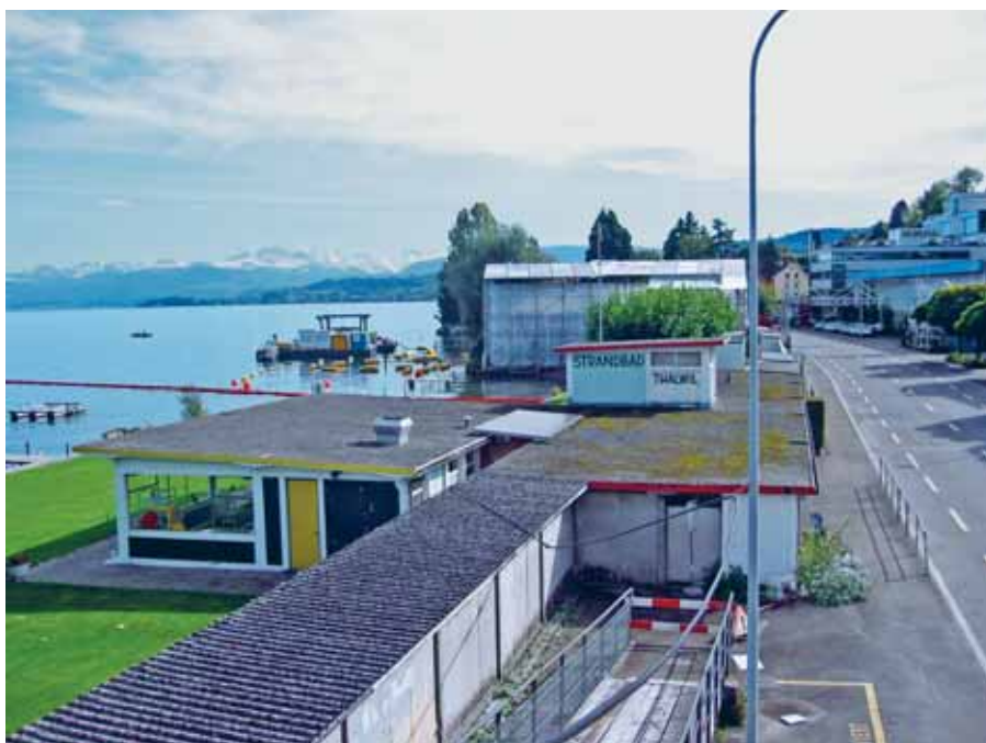
Seit Jahren bedeckte ein Teerteppich vor dem Strandbad Thalwil den Seegrund. 2008 begannen die Sanierungsarbeiten.
