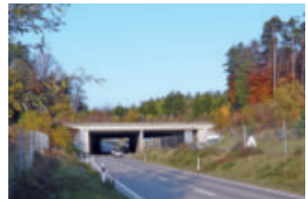
Die beiden Überführungen Rütibuck (oben) und Loterbuck (unten) sollen helfen, die Barrierewirkung von Strassen zu reduzieren.
