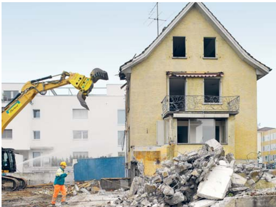
Ein kontrollierter Gebäudeabbruch mit Materialtrennung ist Voraussetzung für die gezielte Aufbereitung und hochwertige Verwertung.
