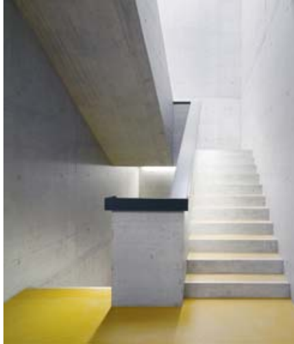
Kleintierklinik: weitgehend aus Recyclingbeton.
