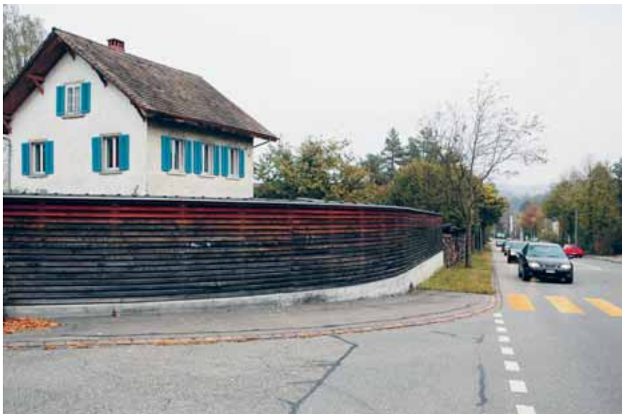
Privat erstellte Lärmschutzwand in Illnau-Effretikon mit traditioneller Materialwahl.
