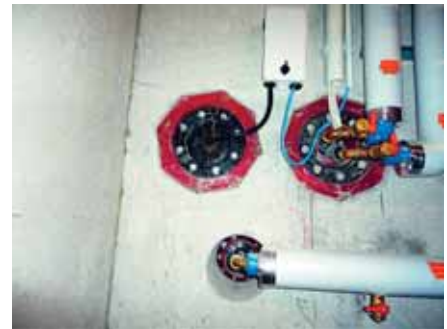
Dichte Rohrdurchführungssysteme.
