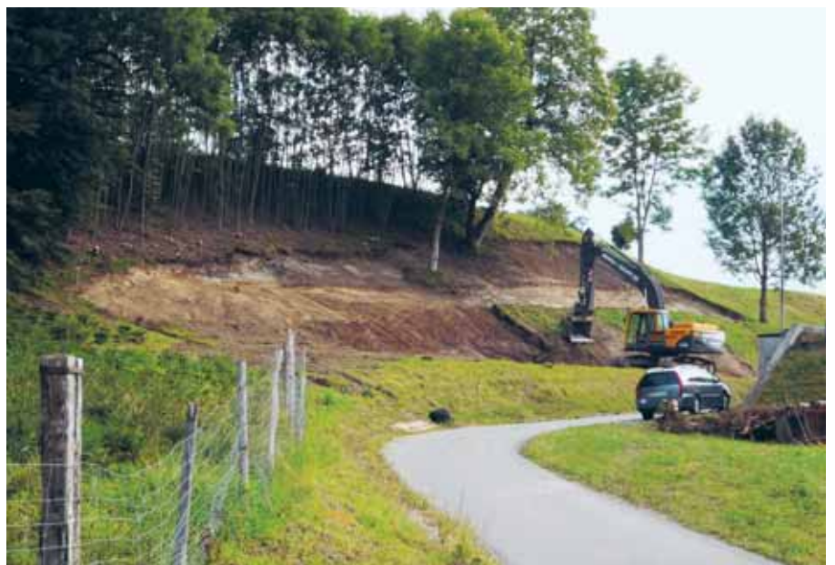
Abtragen des kontaminierten Erdreichs bei einer Sanierung des natürlichen Kugelfangs.
