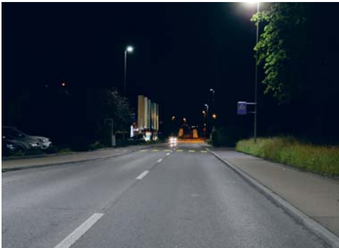
Zur Unfallprävention müssen Zebrastreifen gut sichtbar sein. Das Tiefbauamt hat in Höri mit LED (links) und Natriumdampflampen (rechts) die Beleuchtungsverhältnisse getestet.
