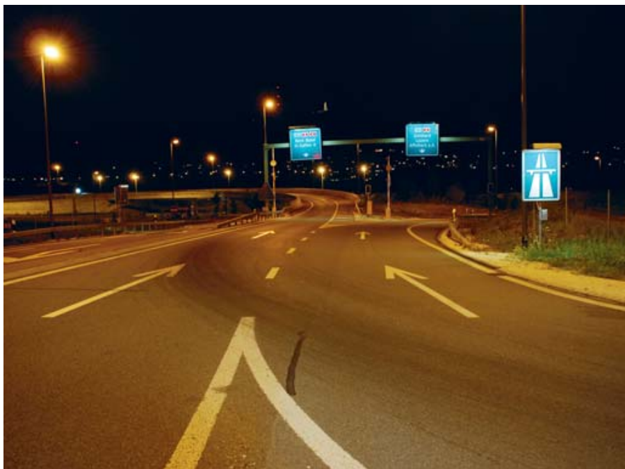
Auch mit Natriumdampflampen sind die Kantonsstrassen bereits heute hell genug und energieeffizient beleuchtet.
