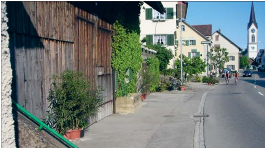
Strassenraum in Benken: Die kleinteilige Abfolge unterschiedlicher Räume macht den historisch gewachsenen Reiz des Ortes aus.
