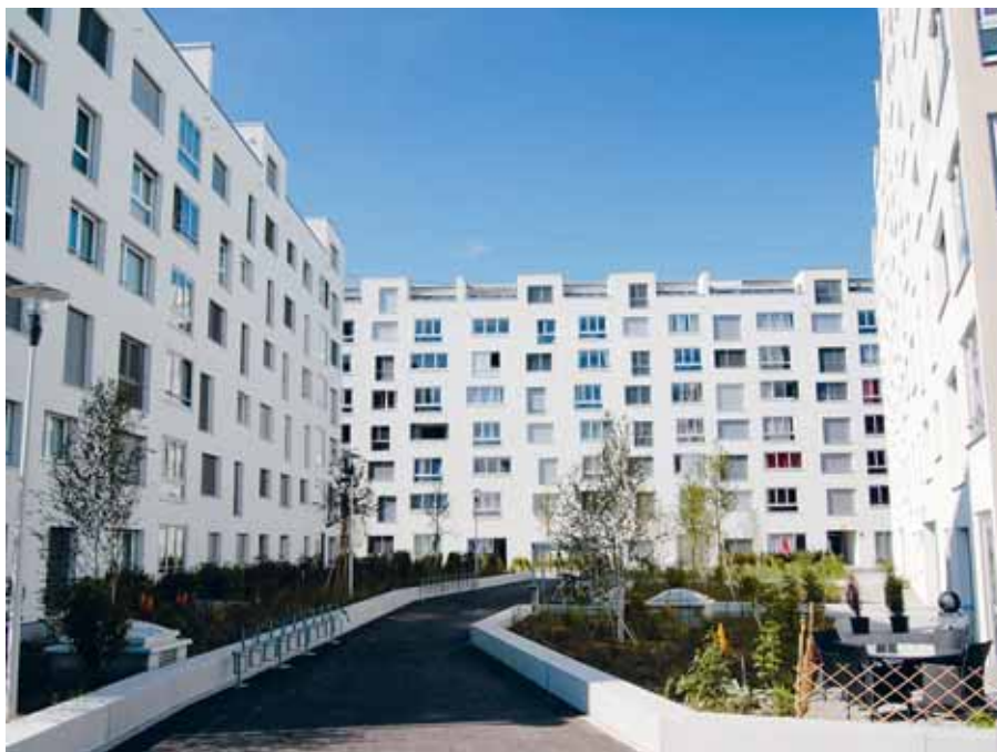
Siedlungsqualität ist ein facettenreicher Begriff, die Gleichung tiefe Dichte = hohe Qualität und umgekehrt gilt nicht. Im Bild: Vorbildliche Überbauung im Glattpark.
