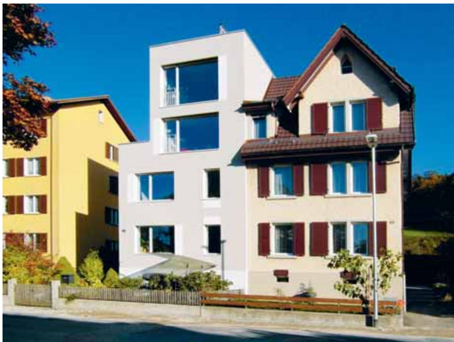
Die energetische Sanierung bestehender Gebäude soll mit den neuen Vorschriften erleichtert und gefördert werden.
