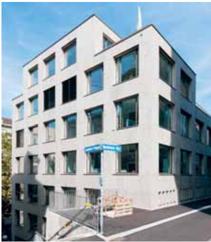
Die Ansicht der Rückseite, wo auch die Begegnungsterrassen liegen.
