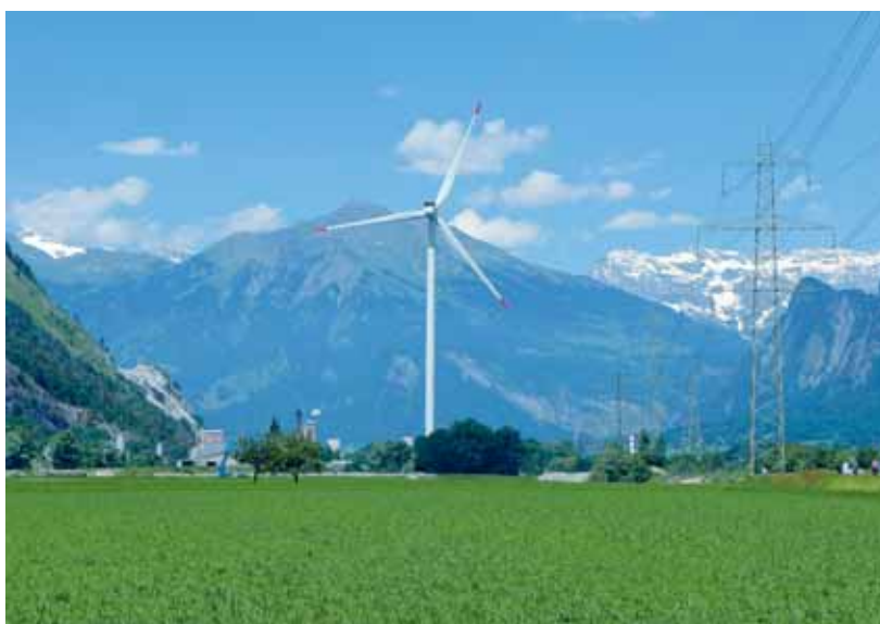
Grosswindanlage in der Gemeinde Haldenstein im Bündner Rheintal. Quelle: Calandawind
