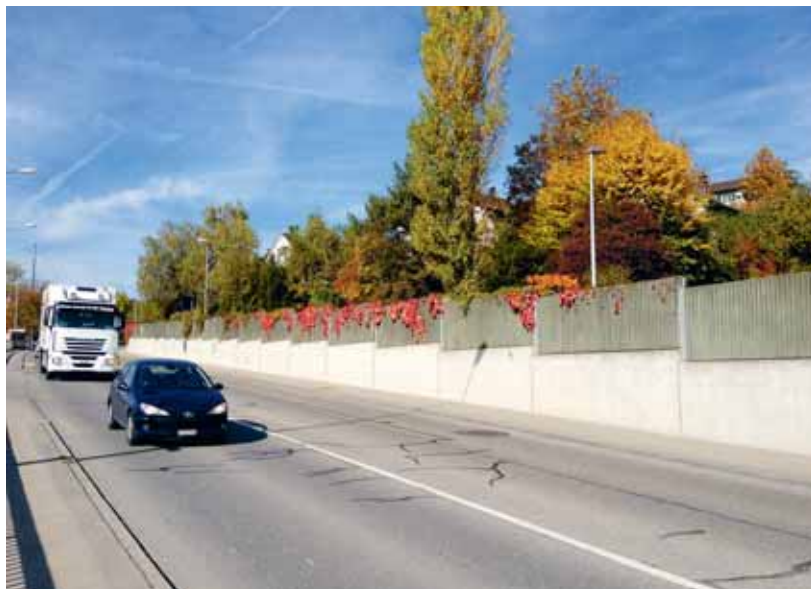
Lärmschutzwand in Eglisau: Eine solche Wand wirkt einerseits trennend, bei derart hohem Lärmpegel sind die Anwohner jedoch froh über diese Lärmschutzmassnahme. Quelle: FALS
