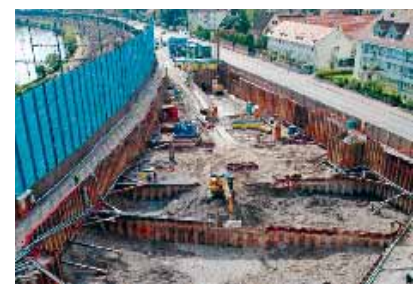
Im Rahmen von Bauvorhaben werden grosse Altlastenflächen dekontaminiert bzw. saniert.
