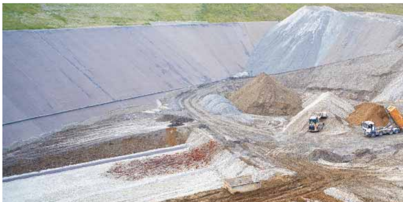
Deponie Häuli, Lufingen: Auch das Deponieren unterliegt einem kontinuierlichen Verbesserungsprozess. Rückstände zur Lagerung sollen immer schadstoffärmer werden. Im Bild: Abdeckung und Überwachung des Sickerwassers. Quelle: : Häuli, Lufingen
