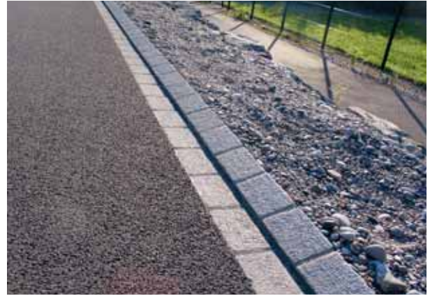
Abgeschrägte Randsteine ermöglichen den Tieren, die Strasse rechtzeitig zu verlassen. Quelle: Simon Gaus
