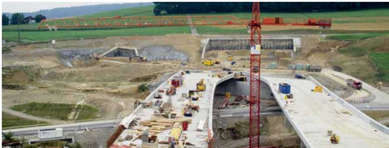
Durch Infrastrukturbauten, wie zum Beispiel den Bau der A3 in Birmensdorf, werden umliegende Böden temporär genutzt und anthropogen belastet. Die Rekultivierung kann sie anschliessend wieder aufwerten.
