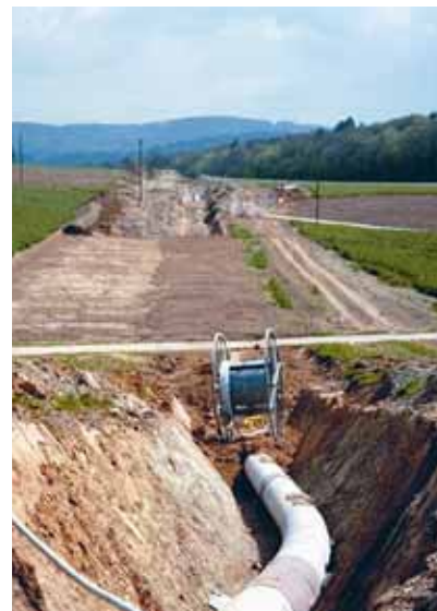
Beim Leitungsbau werden überraschend grosse Bodenflächen anthropogen belastet. Quelle: FaBo
