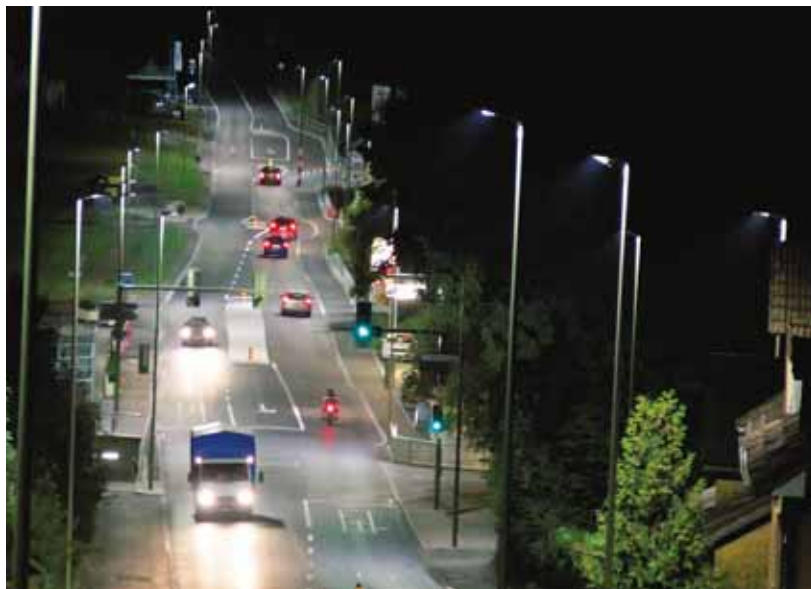
Auf einer rund einen Kilometer langen Teststrecke in Urdorf misst ein Sensor den Verkehrsfluss, woraufhin 27 LED-Leuchten ihre Leuchtstärke anpassen. Quelle: EKZ
