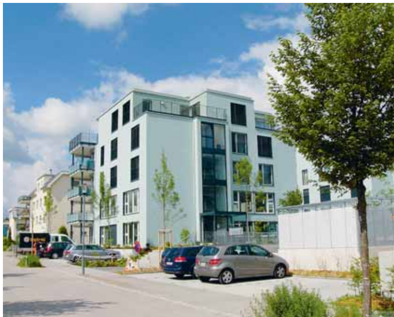
Heute werden auch im ländlichen Raum immer mehr Mehrfamilienhäuser gebaut. Quelle: WikimediaCommons, Nikater (public domain)
