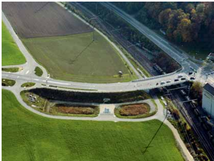
In der SABA Ristet bei Birmensdorf wird das verschmutzte Strassenabwasser mit einem schilfbewachsenen Sandfilter gereinigt, damit der Zustand des Vogelsangbächlis durch die Einleitung des Abwassers nicht verschlechtert wird. Quelle: ilu AG
