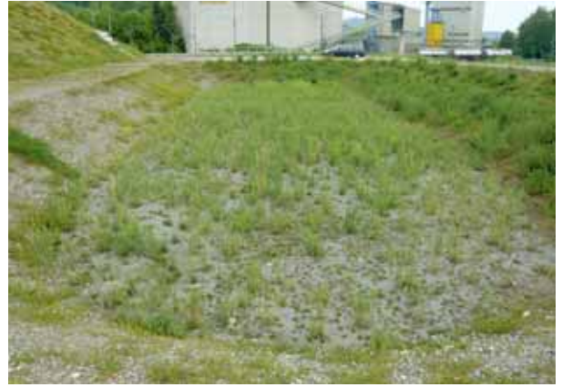
Becken Ost der SABA Ristet Mai 2007.
