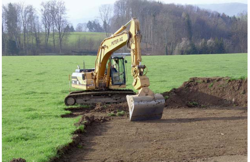
Heute darf Ober- und Unterboden aus Bauvorhaben nicht mehr einfach deponiert werden. Wenn möglich wird er in der Nähe für eine Bodenverbesserung wiederverwertet. Quelle: ALN
