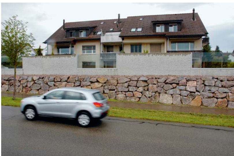
Lärmschutzwände werden nur an speziell geeigneten Orten eingesetzt, wo der Lärm nicht anders an der Ausbreitung gehindert werden kann. Quelle: TBA
