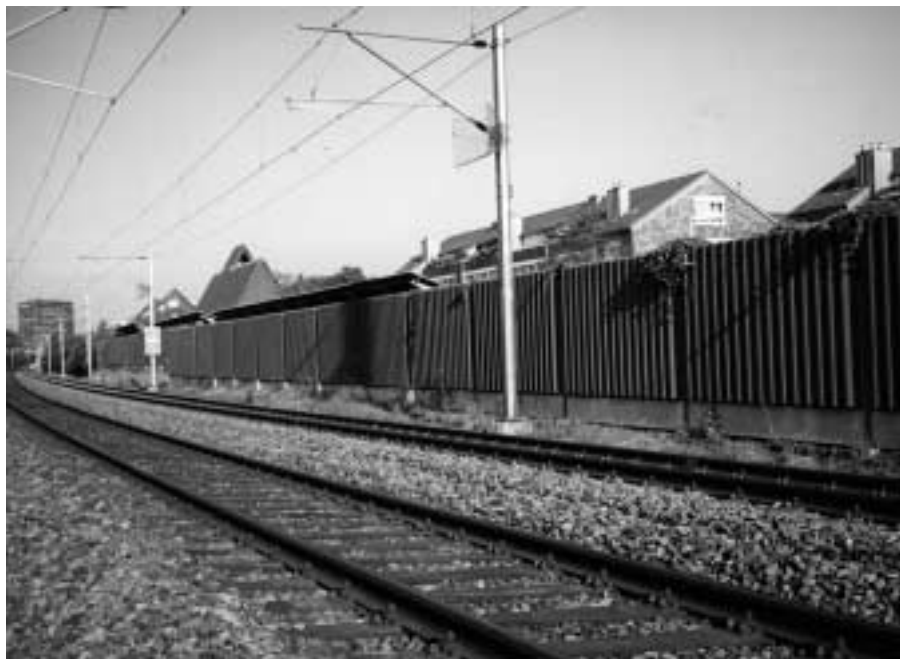
Baulicher Lärmschutz für eine Wohnsiedlung zur Abschirmung des Eisenbahnlärms. Bei entsprechender Gestaltung kann mit einer solchen Massnahme neben dem Einhalten der Immissionsgrenzwerte auch ein lärmberuhigter Vorgartenbereich geschaffen und eine mit dem Ortsbild verträgliche Gesamtwirkung erzielt werden.
