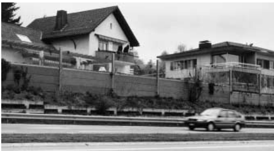
Forchstrasse Zumikon: Der Einsatz von Glas (auf unserer Aufnahme über der Mauer kaum wahrnehmbar) kann den Konflikt zwischen Lärmschutz und Orts- oder Landschaftsbild zum Teil etwas entschärfen.
