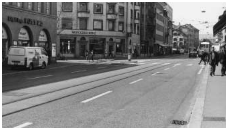
Badenerstrasse Zürich: Der versuchsweise eingebaute lärmarme Belag reduziert den Strassenlärm um etwa 3 dB.
