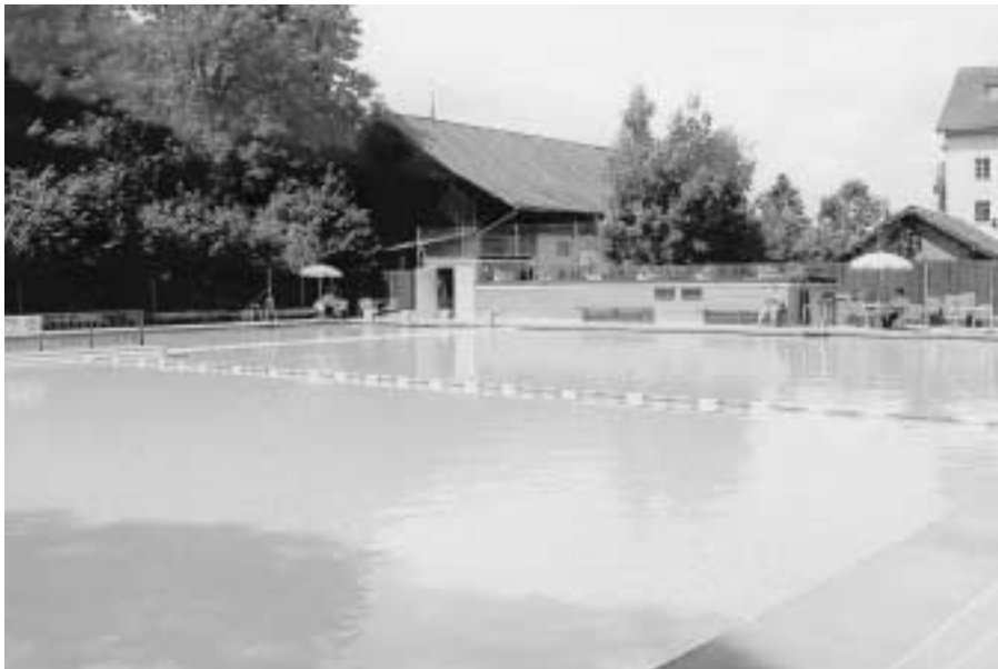
Bäder und Kunsteisbahnen können zu Fallen für deren Besucher werden, wenn bei einer Gasfreisetzung (Chlor oder Ammoniak) die Notausgänge nicht sofort entriegelt werden können. Quelle: Koordinationsstelle für Störfallvorsorge
